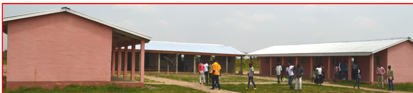
Vue partielle des bâtiments de l'Ecole Normale DNS Mbankana
